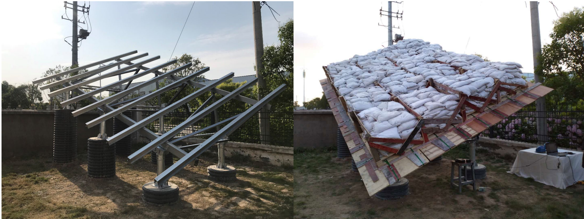
実際の架台 載荷試験風景
